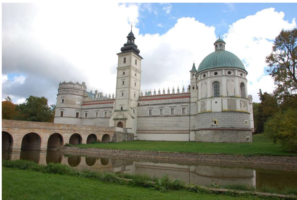
Zamek w Krasieczynie – w widoku na most i Wieżę Zegarową.
